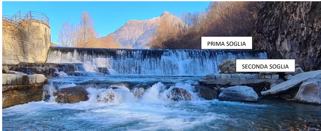
Figura 7: Soglie da demolire – vista da valle
